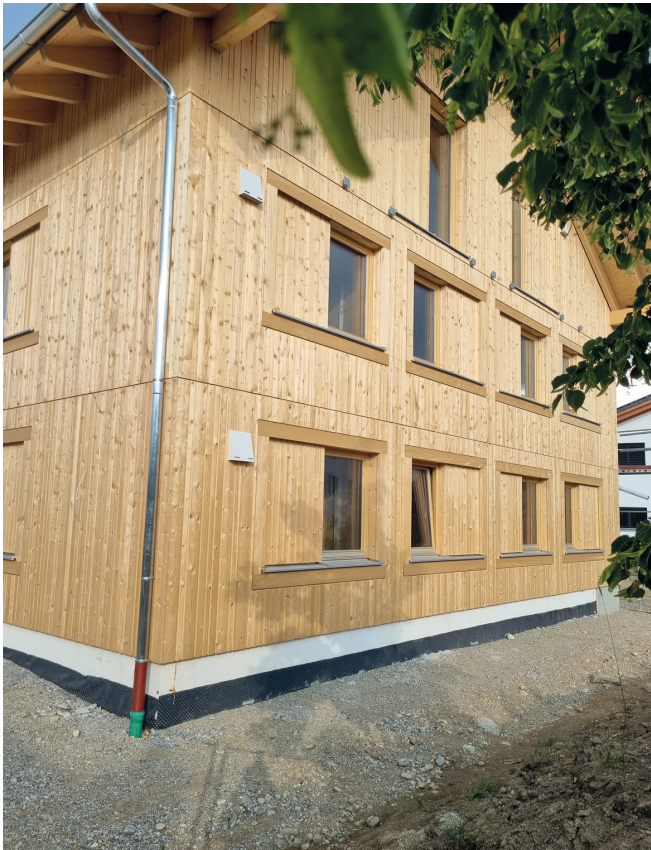
Jetzt neu im Angebot: Wasserburger Tannenfassadenverschalung. Das Bild zeigt die neue Fassade der Baugruppe Evenhausen (Foto: WBV).
