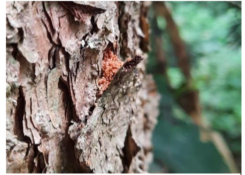
Frisches Bohrmehl hinter einer Rindenschuppe. (Foto: WBV Wasserburg-Haag w.V.)
